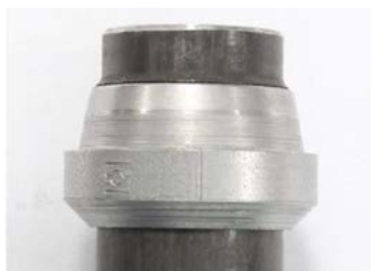
Ilustr. 17: Efekt montażu wstępnego pierścienia zacinającego
