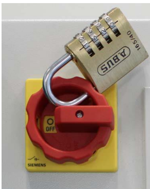
Rys. 2: Główny wyłącznik elektryczny zabezpieczony kłódką
