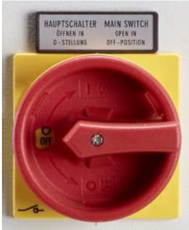
Fig. 2: Interruptor eléctrico principal
