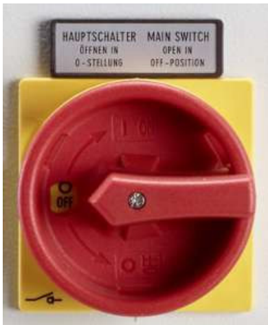
Fig. 2: Interruttore elettrico principale
