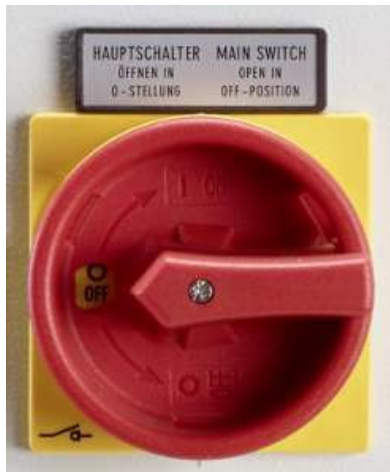
Rys. 2: Wyłącznik główny zasilania elektrycznego
