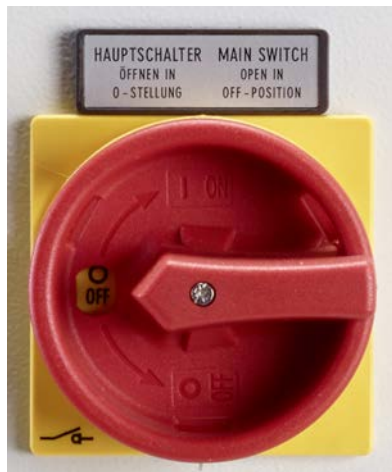
Ilustr. 1: Wyłącznik główny zasilania elektrycznego
