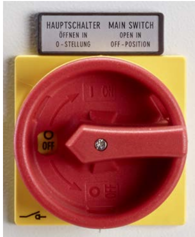
Imag. 2: Interruptor eléctrico principal
