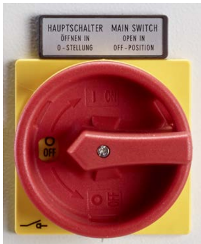
Ilustr. 2: Wyłącznik główny zasilania elektrycznego
